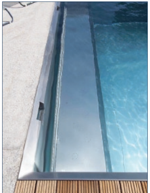
Skimmer (Eigenfertigung), Unterflurrollladenabdeckung mit Sitzbank und Luftsprudelsystem
