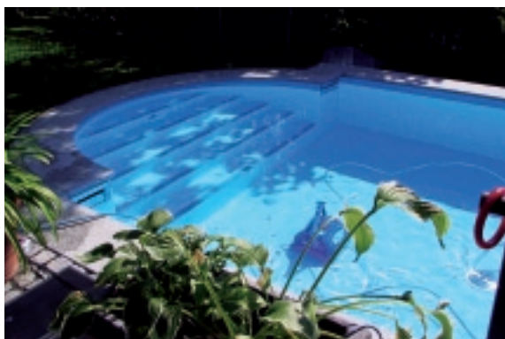
Einstückbecken privat 4 x 9 m mit römischer Treppe.
